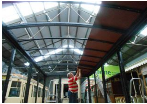
De montage van het dak
